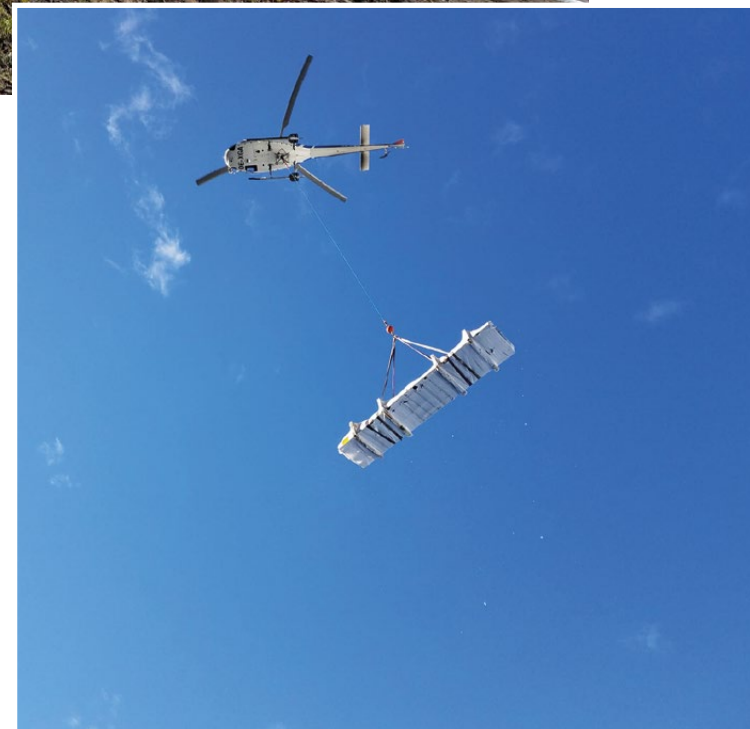
Für die Anlieferung des Baumaterials in entlegene Bereiche waren Hubschrauberflüge notwendig.
