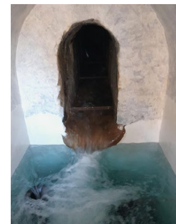
Mündung des Quellstollens nach Abschluss der Grobarbeiten, Restarbeiten folgen.
