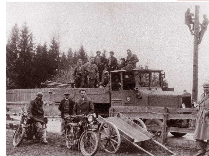
Der Leitungstrupp bei der Errichtung der Strommasten und Stromleitungen.
